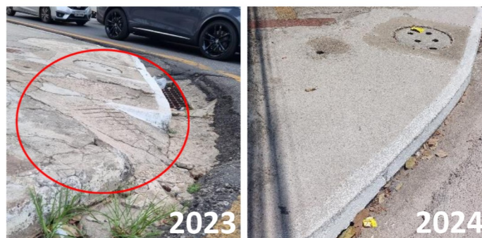
Figura 1 – Antes e depois da rampa na Avenida Almirante Barroso, bairro Souza.
